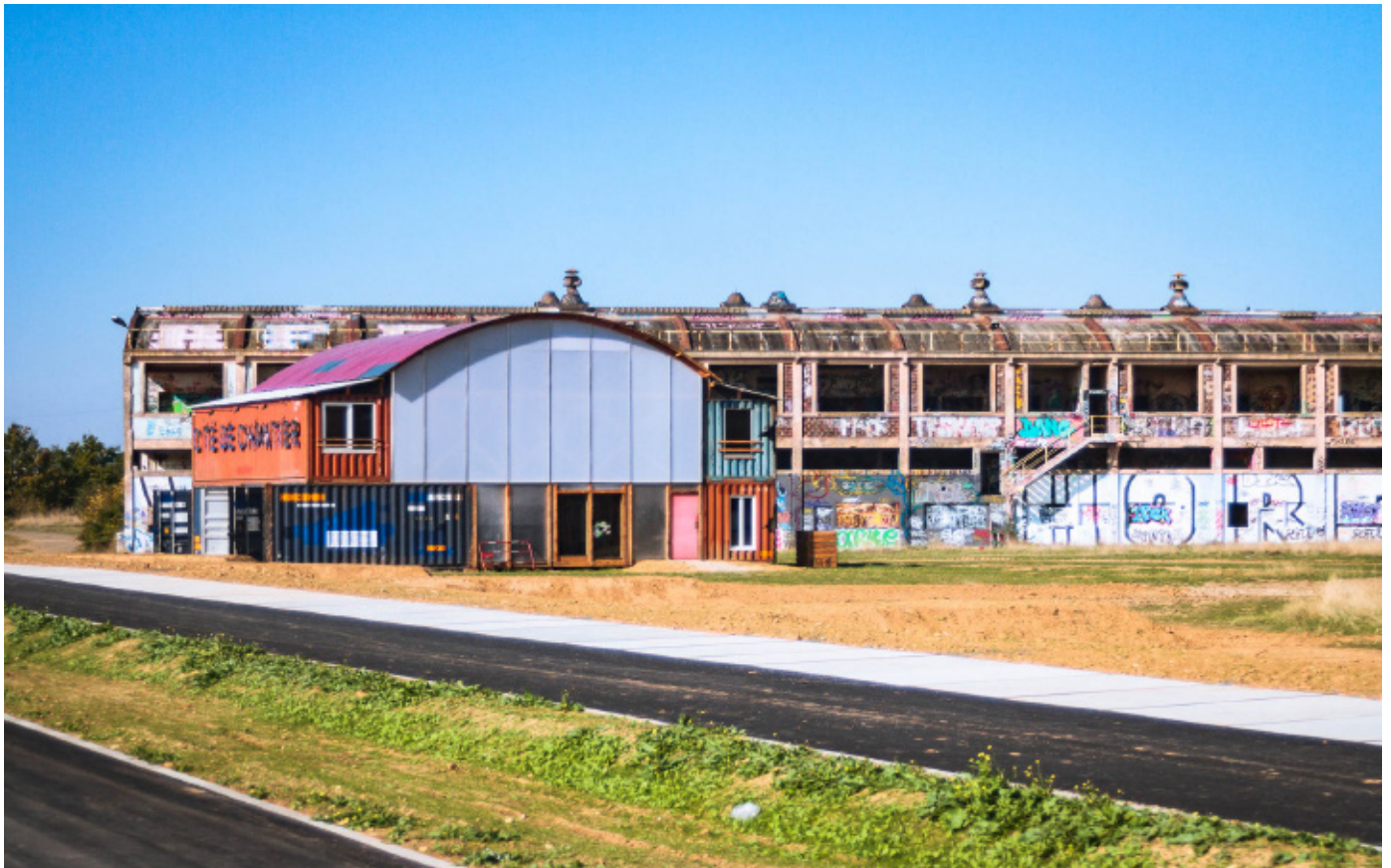
▲ La Cité de chantier du Wip, sur la friche de la SMN à Colombelles Crédits : Alexandre Andurand (2016)
